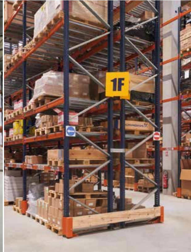
Protection latérale avec un profil
