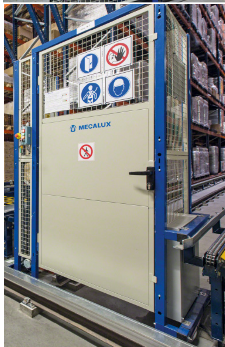
Cloisons de zones de contrôle et de maintenance.
