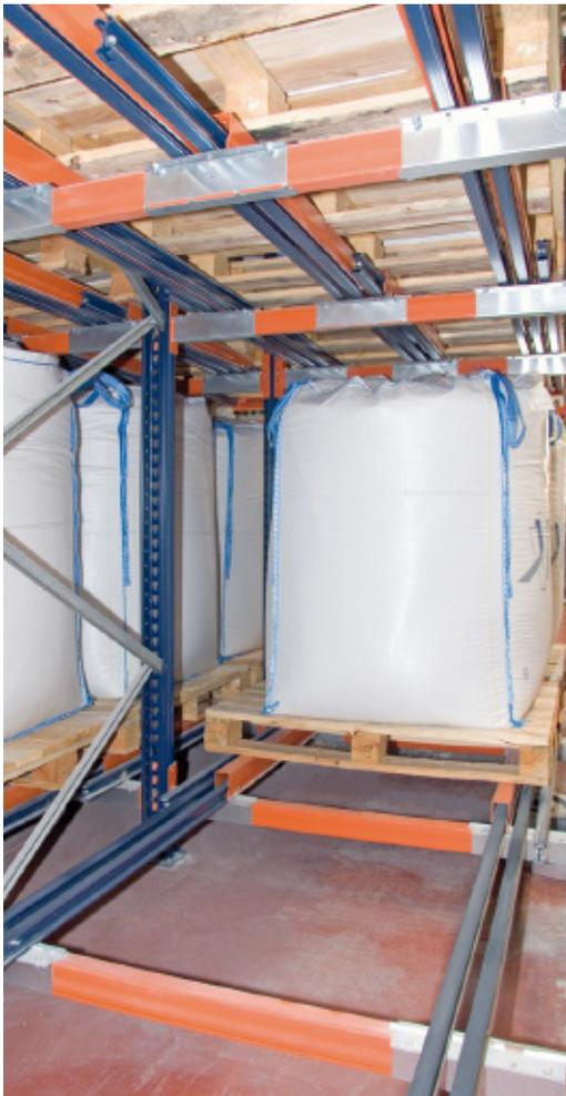
En plus des éléments communs aux rayonnages à palettes (comme les montants, lisses, traverses, diagonales, ancrages, etc.), le système push-back comprend également des rails de roulement, des chariots PB et différents dispositifs de sécurité :
