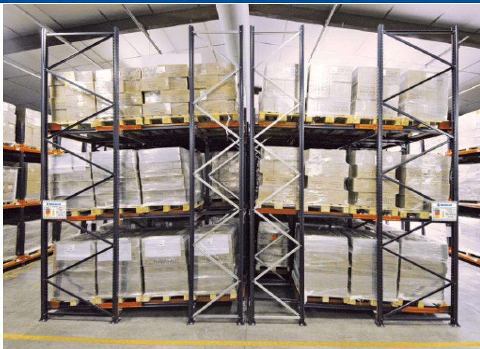
1. Un **niveau unique de picking dynamique au niveau inférieur**, et dans lequel les palettes stockées aux niveaux supérieurs sont placées (figure 1).
