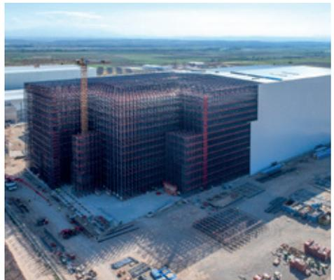
HAUTEUR MAXIMALE DE CONSTRUCTION : LES ENTREPÔTS PEUVENT MESURER DE 12 MÈTRES À 45 MÈTRES DE HAUTEUR.
