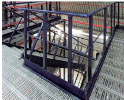
**Garde-corps.** Les garde-corps de protection sont constitués de tubes ronds et rectangulaires assemblés à l'aide d'ensembles d'union bridés. Sur la partie inférieure, sont installées des plinthes de protection pour éviter que des objets tombent de la plate-forme.
