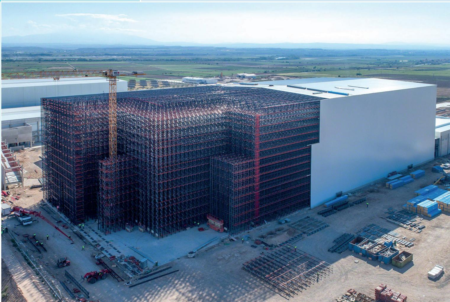
L'entrepôt autoportant constitue la solution la plus satisfaisante pour le stockage de grande hauteur, car il est conçu pour que les rayonnages supportent la toiture et les parois, évitant ainsi la construction d'un bâtiment.
