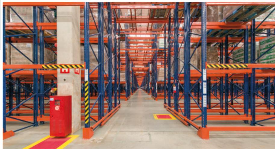
Mecalux a équipé l'entrepôt d'Unilever au Brésil avec des rayonnages à palettes simple et double profondeur, pour une capacité de stockage totale de 83 569 palettes. Cette solution permettra à l'entreprise de répondre à la demande de ses clients et de tenir son rythme actuel de croissance en Amérique latine.
